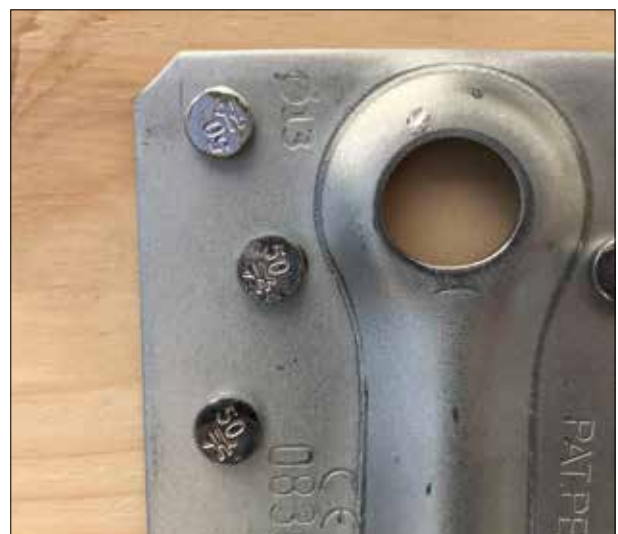
Le marquage sur le connecteur, en plus du marquage sur les têtes de pointes, permet une vérification facile après la pose
