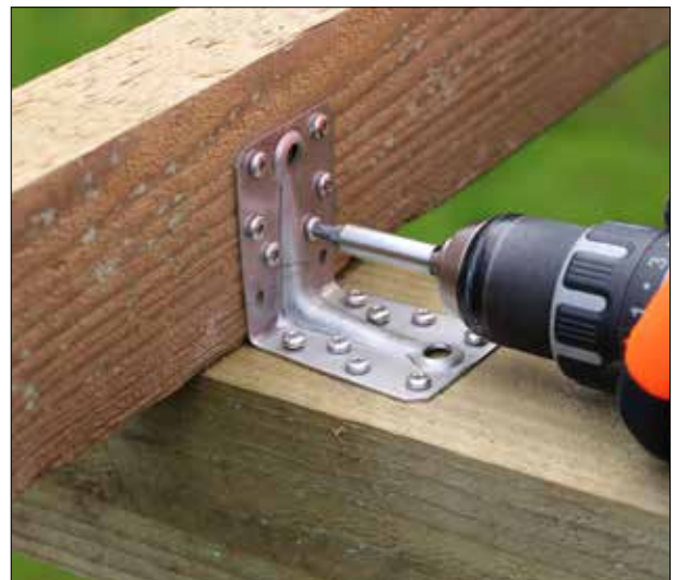
ABR7015S en acier inoxydable A4 installé avec des vis de fixation CSA-S en acier inoxydable A4
