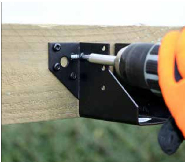
Sabot SAE-PB noir installé avec des vis CSA-PB
