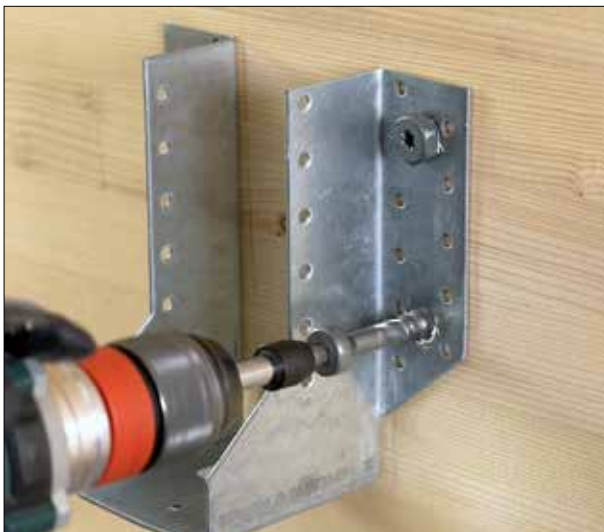
Sabot SAE installé avec SSH
