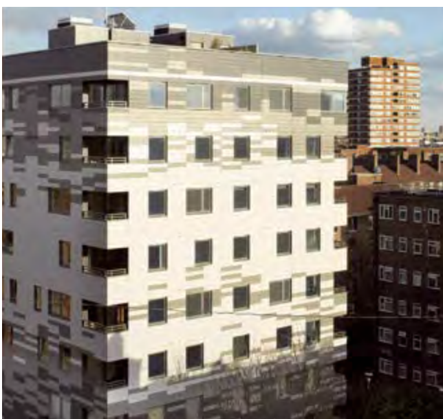
Immeuble résidentiel Murray Grove, Royaume-Uni
