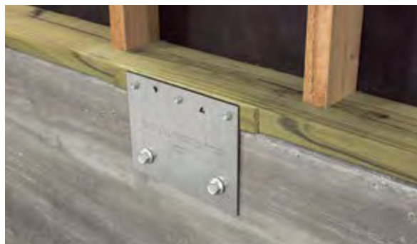
Renforcement d'un assemblage par les fondations
