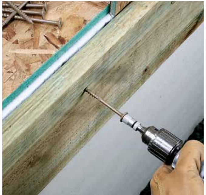
Vis SDWS utilisée pour la fixation de muralière
