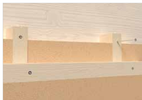
TTUFS utilisée dans les ossatures légères
